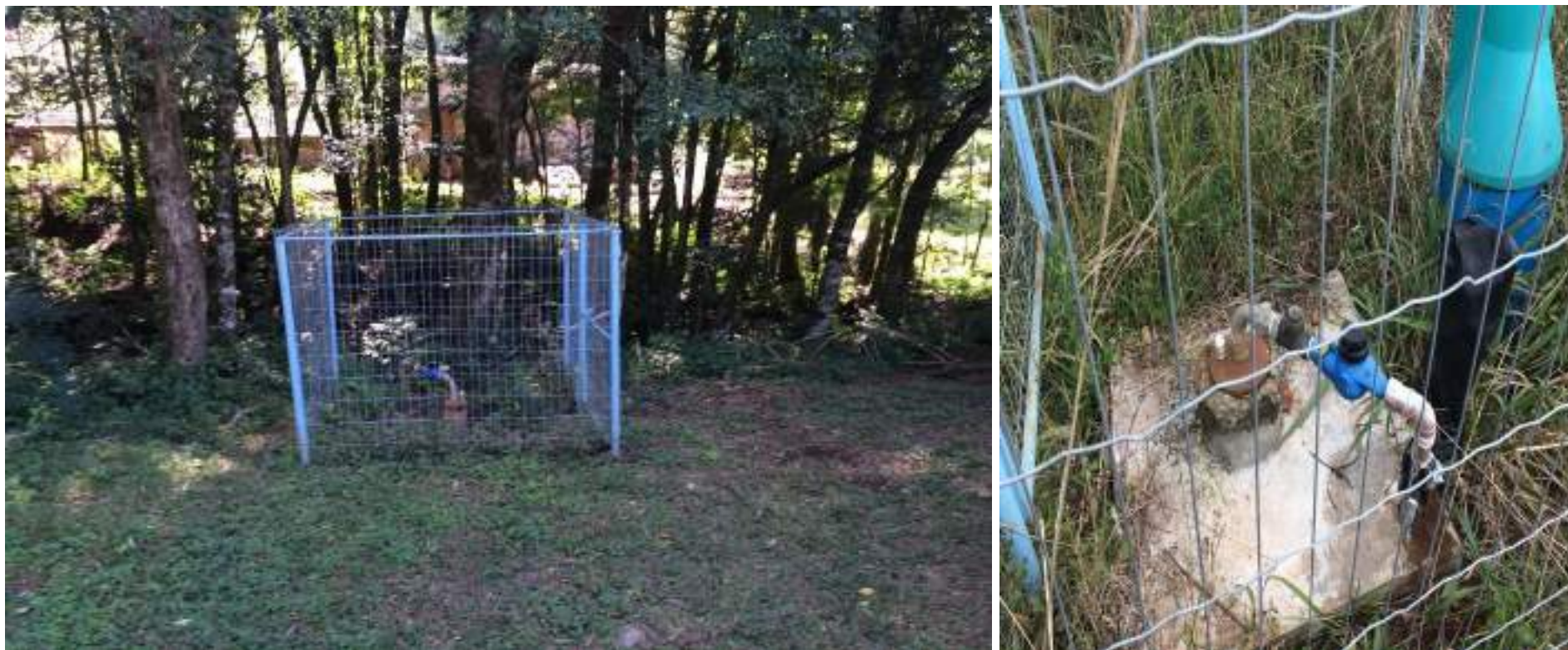
Foto 7 - Estruturas dos pontos de captação de água na zona urbana e rural.
