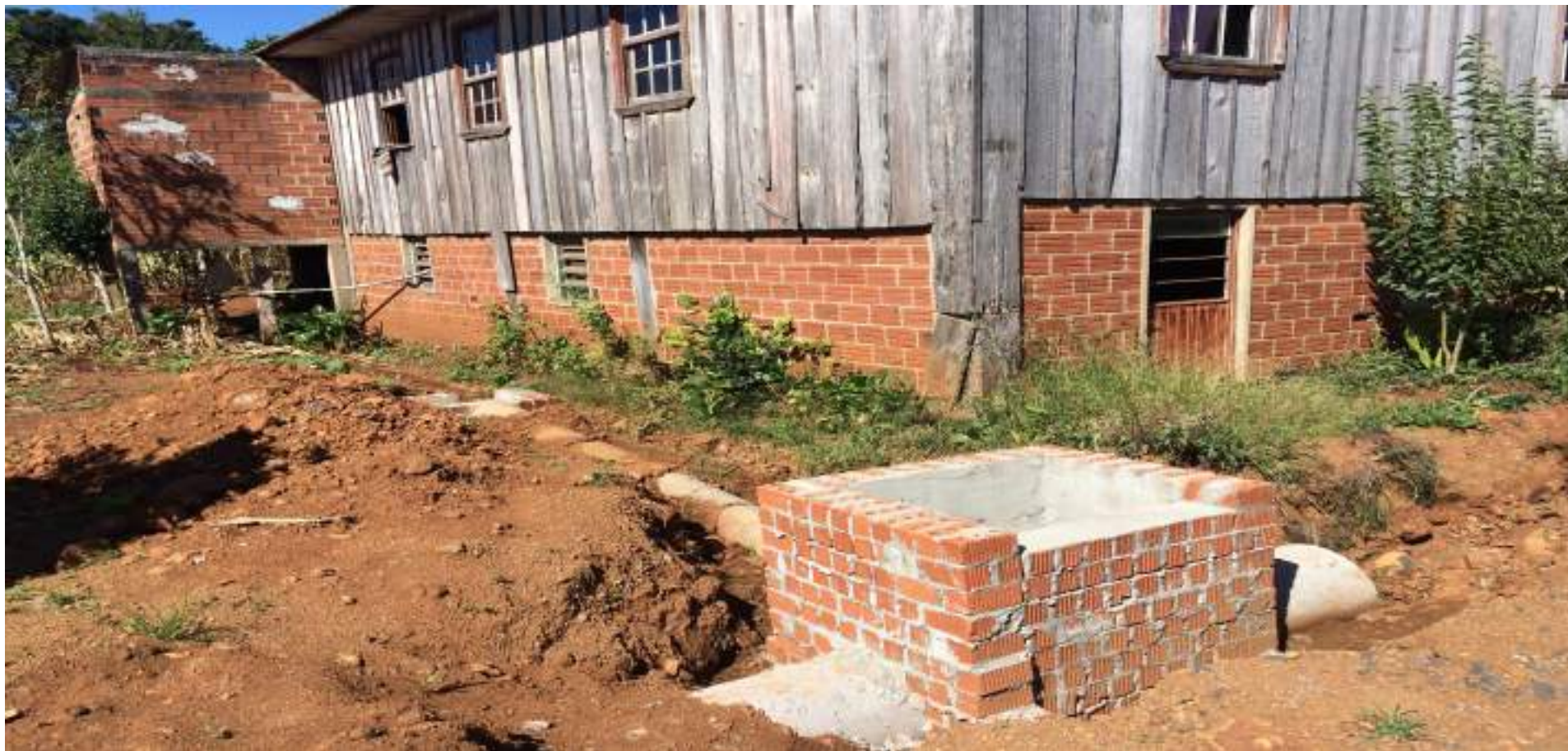
Foto 1 - Vista parcial de ligações de esgoto sanitário domiciliar em rede de drenagem pluvial urbana.
