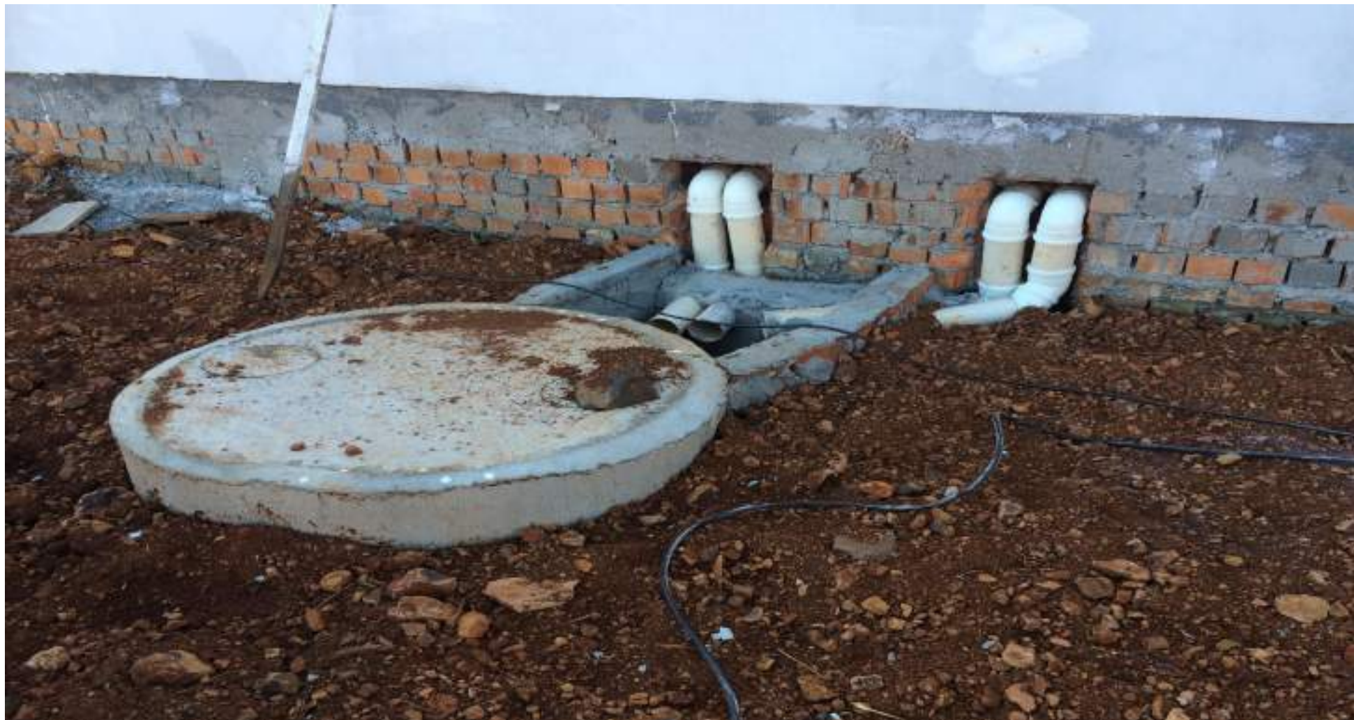
Foto 2 - Vista parcial de sistema de tratamento de esgoto individual – fossa e filtro.
